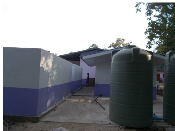
ถังเก็บน้ำ ความจุ ๑๐๐ ลูกบาศก์เมตร
